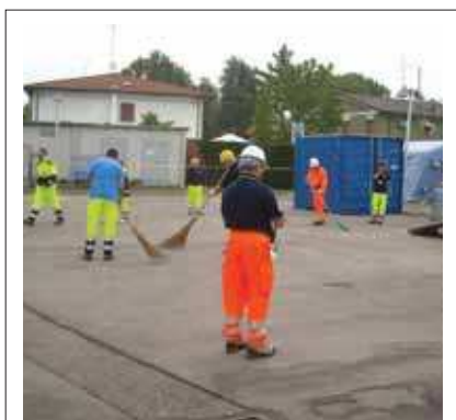
La pulizia del piazzale prima del montaggio del tendone-mensa
