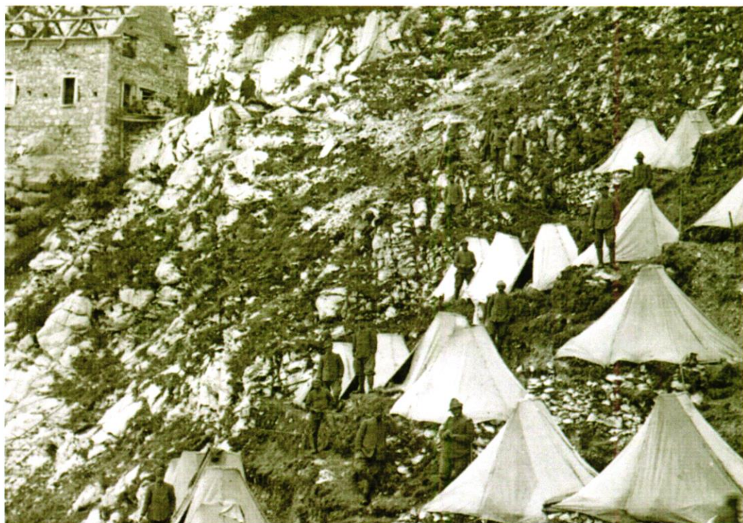
Costruzione di un ricovero e accampamento di alpini
