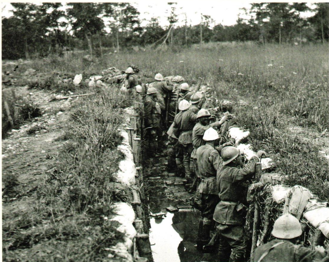
Trincea italiana lungo l'argine del Piave
